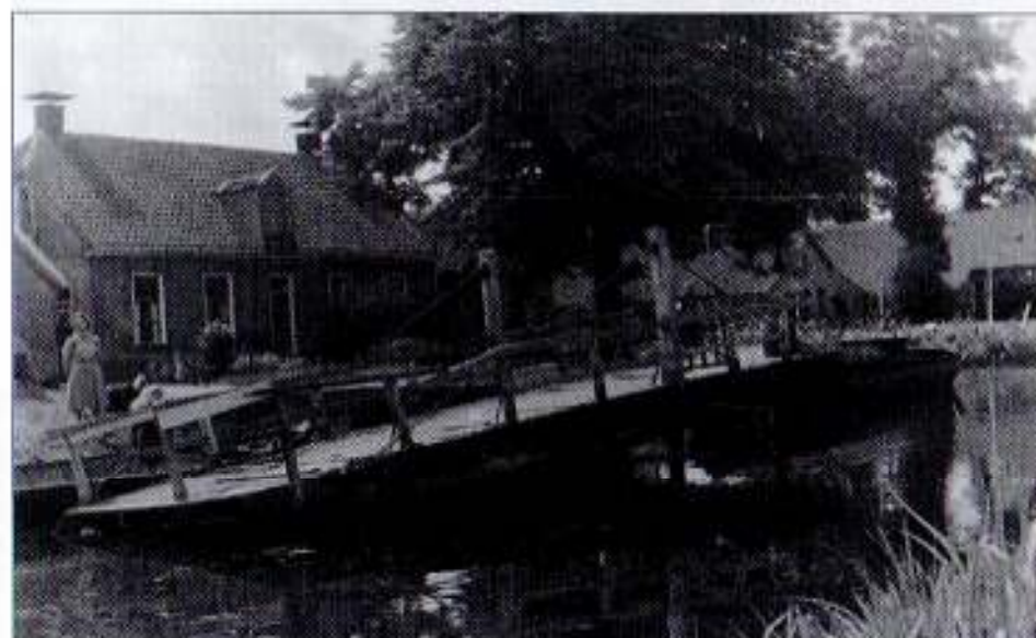
Houten draaibrug in slechte toestand. Op de achtergrond scheepswerf Mol, later Geertman.
