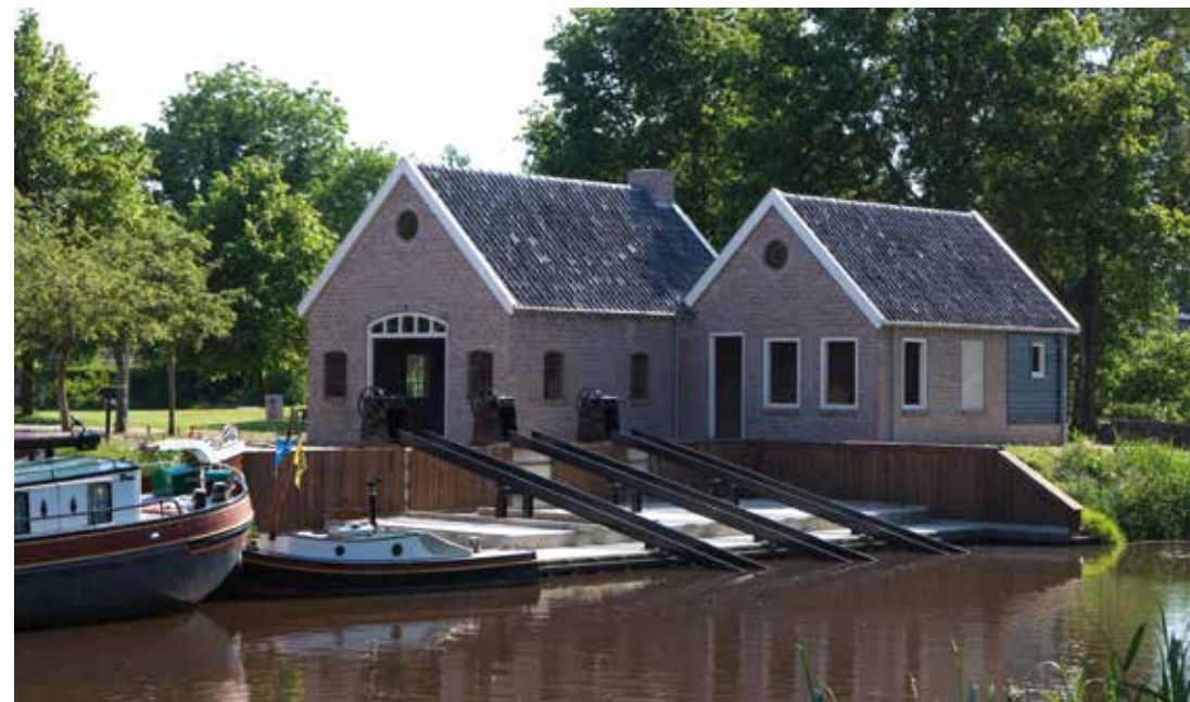
Het hellingspoor en de lieren zijn geplaatst. (Collectie HVA)
